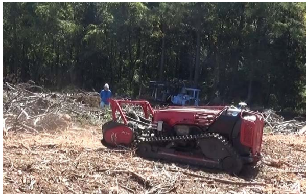
写真 1-13 前進破碎状況
