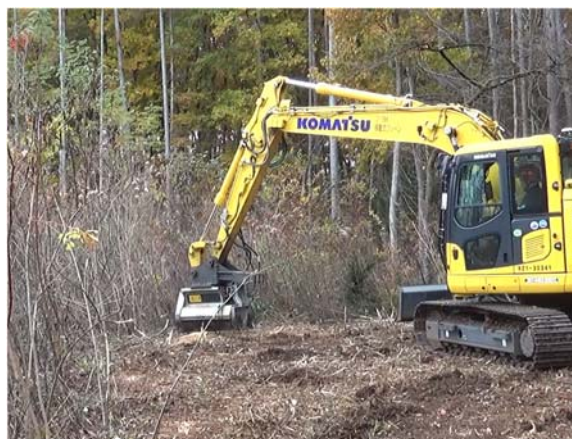
写真3-12 伐根切削破碎
