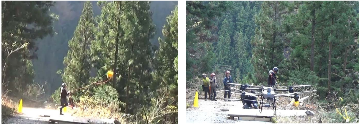
写真 4-15 リードロープ受取状況（左）とロープ取り外し状況（右）
