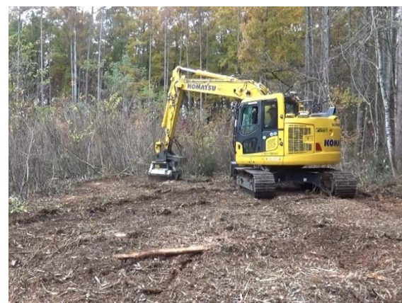
写真3-11 地表面(A0層)破碎(右旋回)
