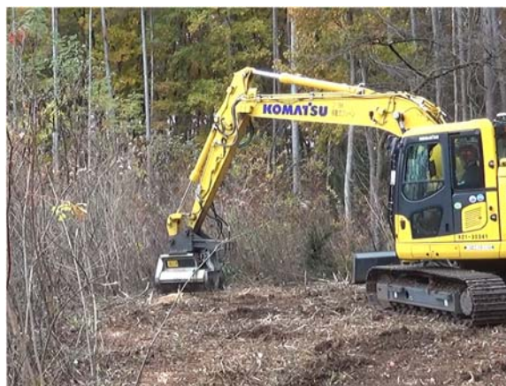
写真3-12 伐根切削破碎
