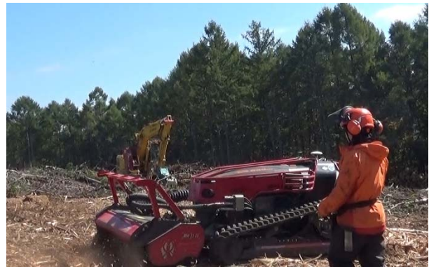
写真 1-14 後退破碎状況
