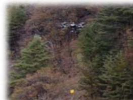
先端技術: 貨物運搬用ドローン架線架設リードロープ引き回し
