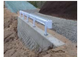
コンクリートブロック擁壁
