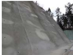
コンクリート吹付工
