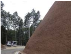
厚層基材吹付工
