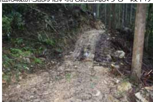
写真4-39 洗い越し工部の縦断勾配事例
