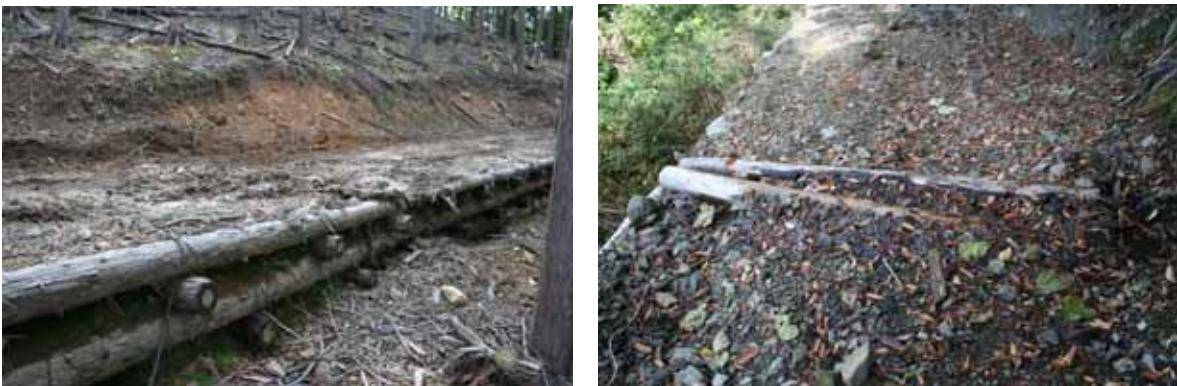
写真 4-50 丸太構造物と路面排水の関係
