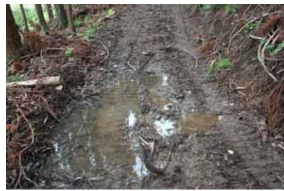
写真 4-30 縦断勾配変化点での滞留事例
