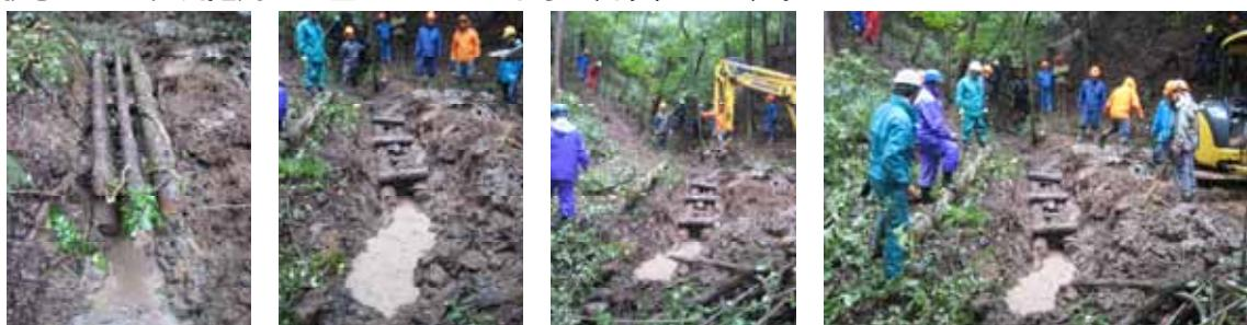
写真4-40 洗い越し工の作設事例
