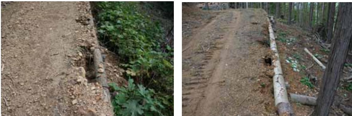
写真 4-52 中詰め土砂の流出による路肩変状
