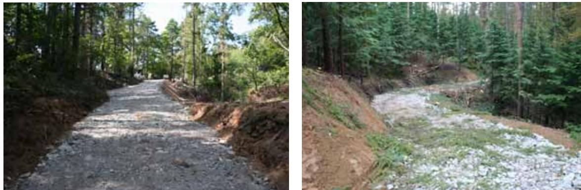
写真4-61 現場発生材を用いた路面工(左)と破石(切込み破石・栗石)を用いた路面工(右)
