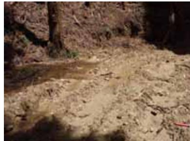
降雨時の越流で路面が荒れた越流部。排水機能が劣り、水流が路面上で滯水している。
