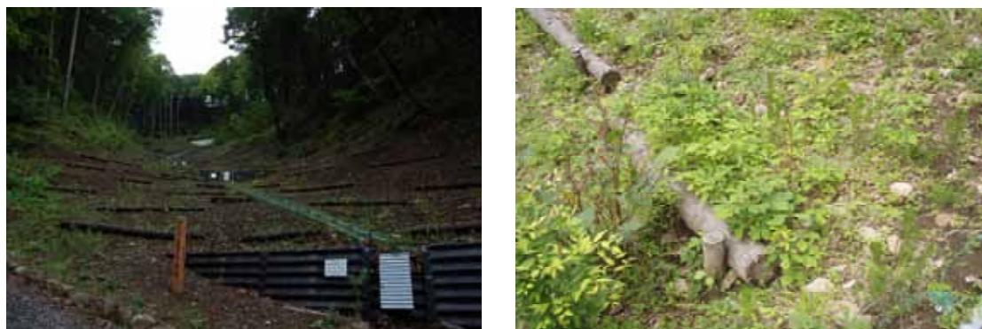
写真4-26 伐木筋工の事例（岡谷市、平成18年7月豪雨災害復旧現場）
