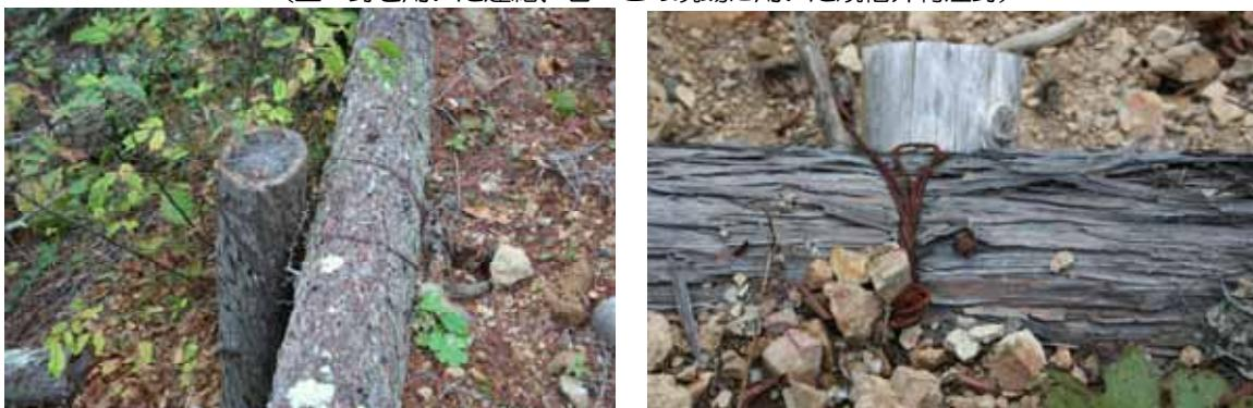
写真4-56 鉄線を用いた1重連結（左:なまし鉄線#10）と鉄筋を差し込んだ事例（右）
