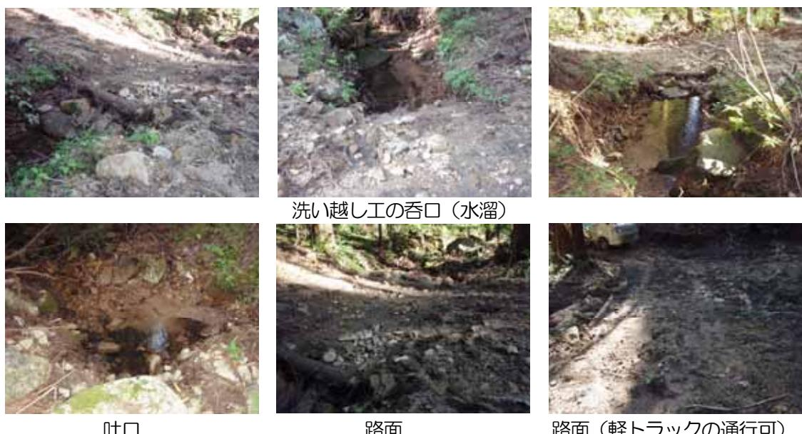
写真4-41 洗い越し工の呑口・吐口と路面
