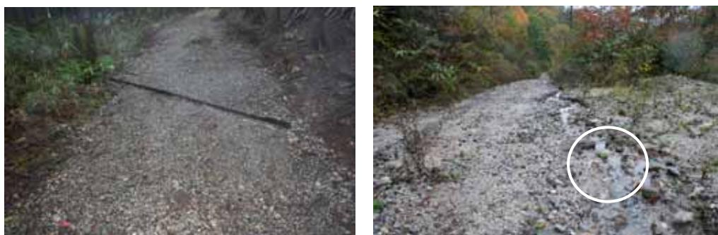
写真4-34 排水効果を発揮しているゴム製水切工（左）と
