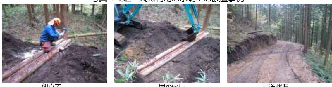
写真4-33 現場作成水切工（横断溝タイプ）の設置事例
