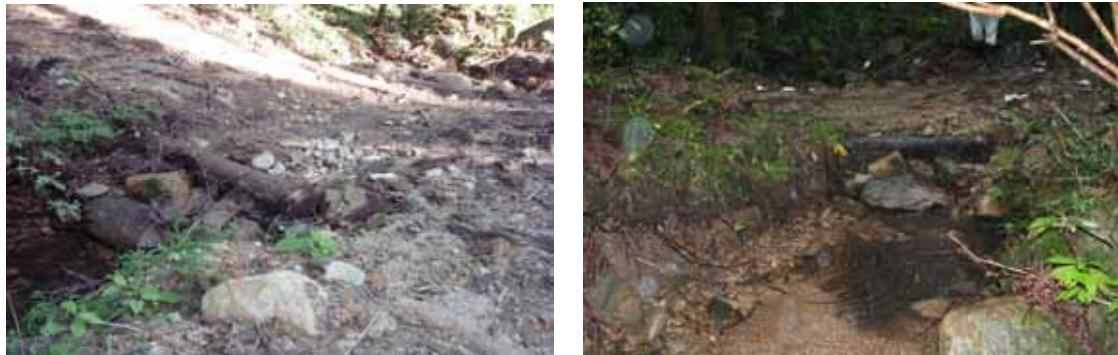
呑口側は、流速を弱めるように現渓床を掘削して流路断面を広げている。1年間のうちに、数回路面を流水が越流したが、路面の損傷、縦断勾配下方への流下はなかった。
