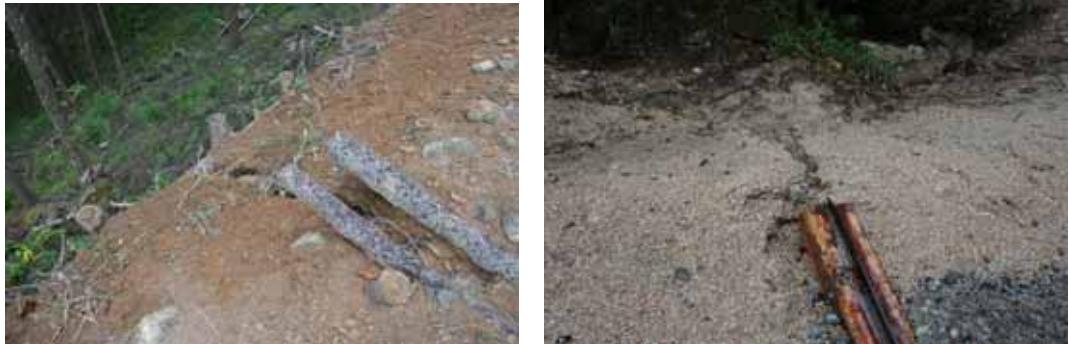
写真4-35 盛土に設置した水切工による盛土法面の侵食
