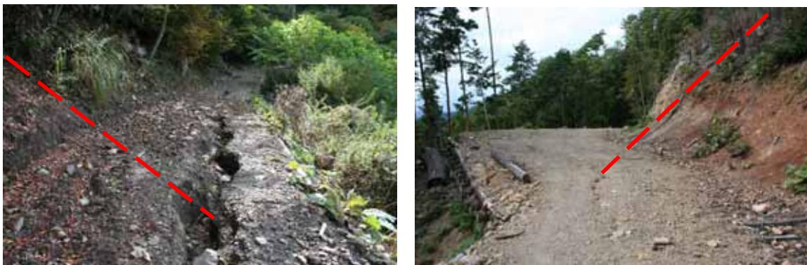
写真 4-51 丸太構造物設置箇所の路肩変状
