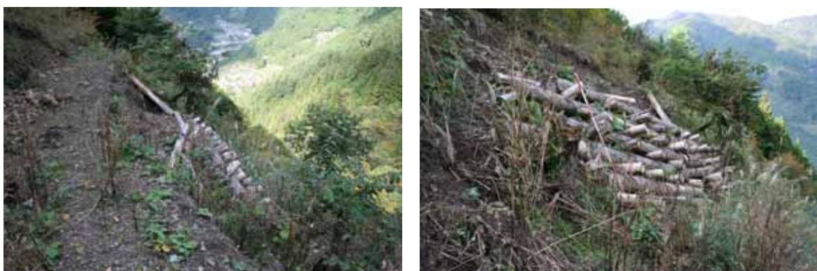
写真 4-46 高さ 2m (7段) の丸太積工法破損した事例
