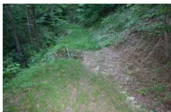
写真4-27 路面侵食が発生した作業道
