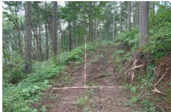
写真 4-29 横断変化点の素掘り排水工
