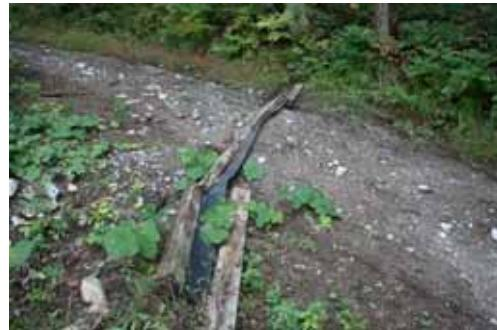
ゴム製水切工の破損
