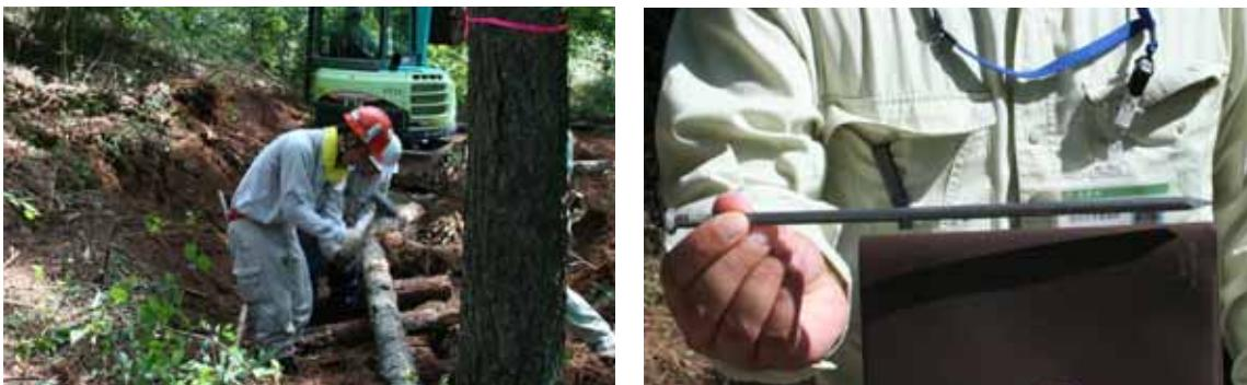
写真4-55 丸太構造物部材連結に用いる釘の状況
