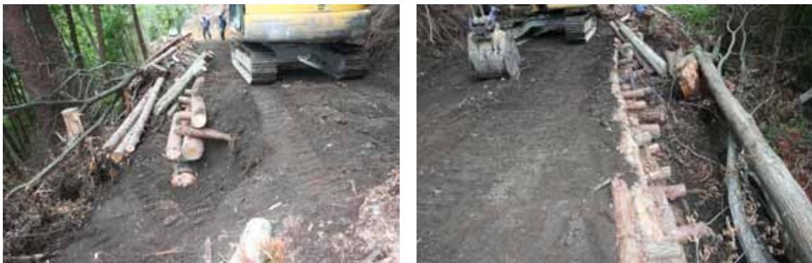
写真 4-53 設置、埋め戻し転圧状況
