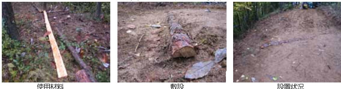
写真4-32 丸太利用の水切工の設置事例
