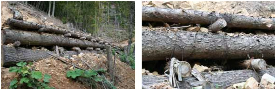
写真 4-54 丸太構造物の中詰め材の状態 (礫質土)
