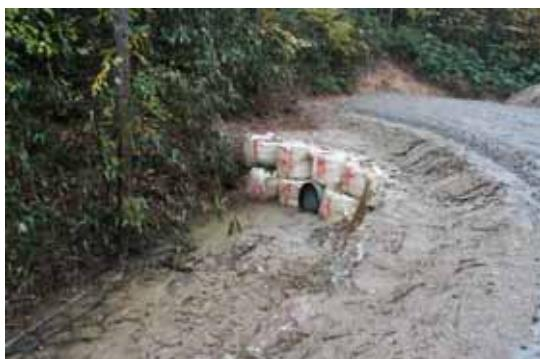
写真4-59 大型土のう設置事例
