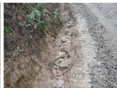
上層路盤工（敷き砂利）をしても急勾配の区間は、路面水が走り、侵食を発達させる。森林作業道は、土側溝は作らず、敷き砂利を行う場合は、全幅に敷き詰めることが理想的。
