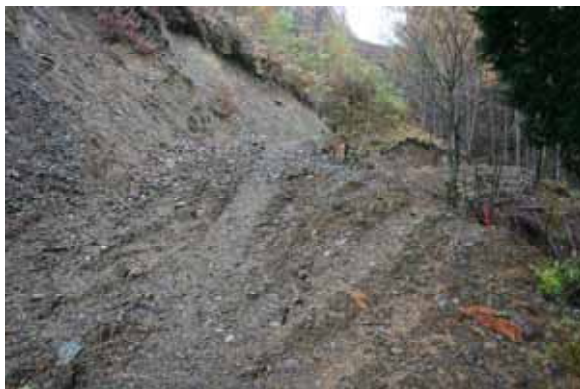
写真 4-20 第三紀砂岩泥岩互層（左）と凝灰岩質の脆弱な岩盤法面
