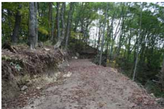
写真.1 切取直、表土積工による路体
