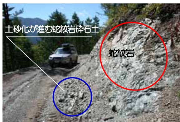
写真 4-21 破碎帯地帯の脆弱な岩盤法面（左）と露頭した蛇紋岩法面（右）
