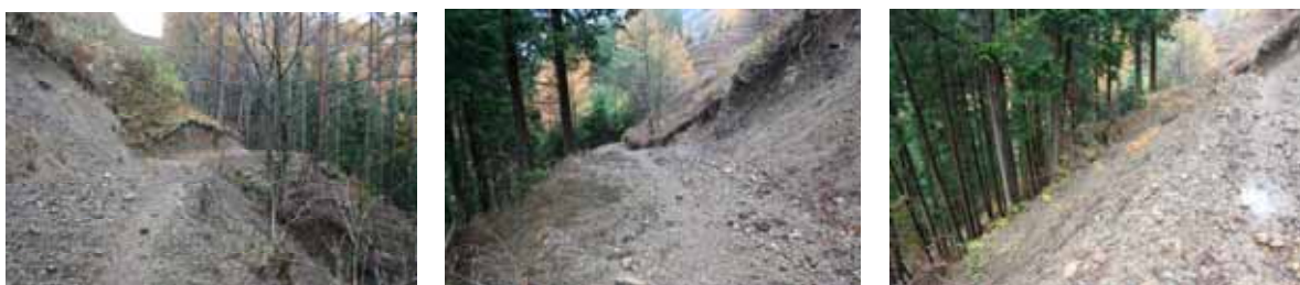
写真 4-15 盛溢しの事例
