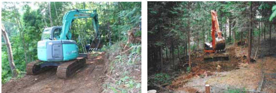
写真 4-23 掘削重機を用いた転圧状況
