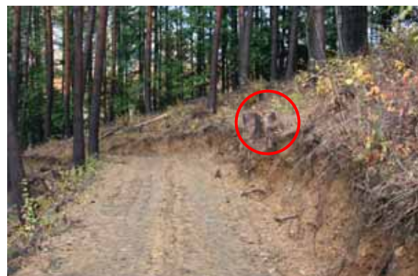
法頭の立木を伐採しても根株を除根しない事例（松本地域） 伐開幅の状況
