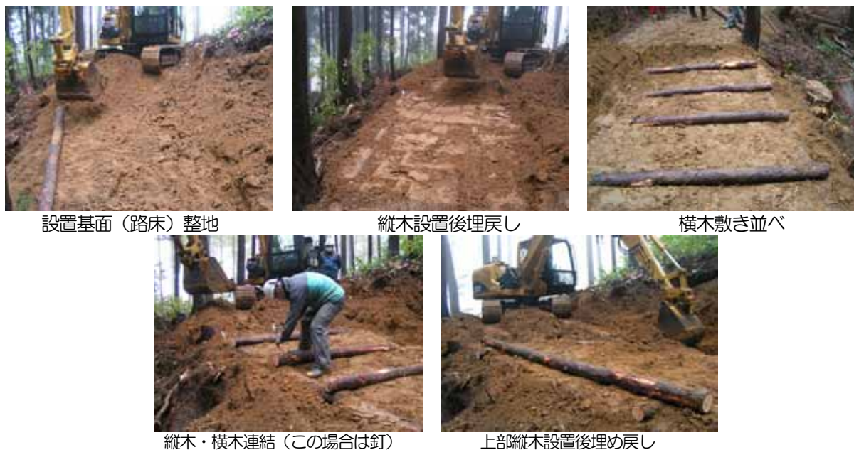
写真 4-24 現地発生井桁組施工の事例
