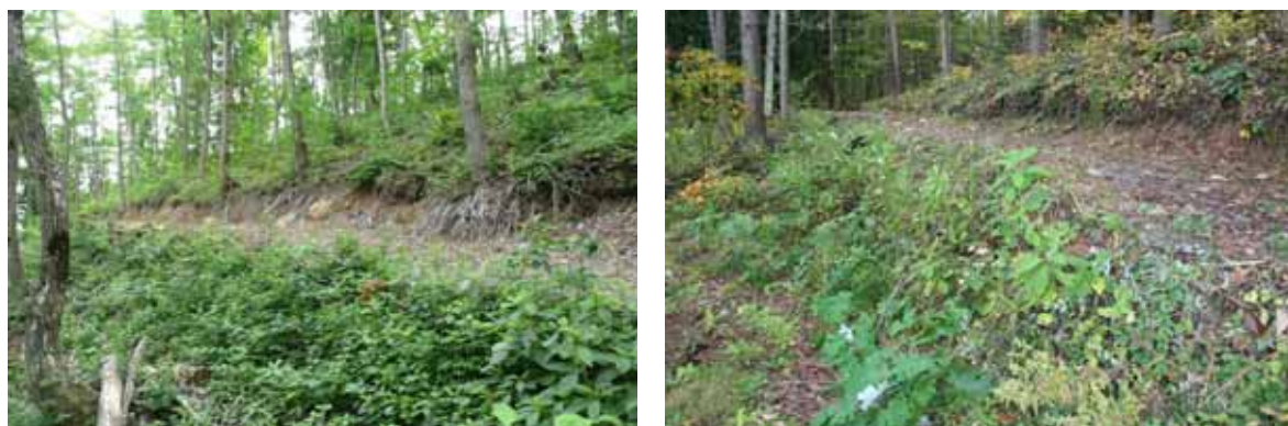
写真 4-25 表土積工の施工事例（施工 1 年後）
