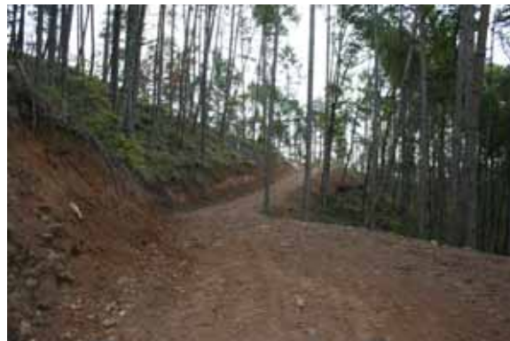
写真.2 切取6分、盛土1割2分による路体
