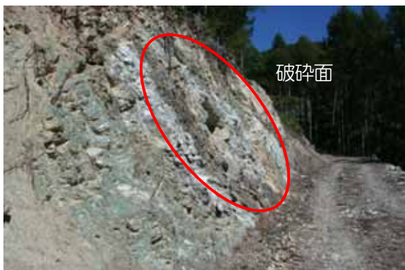
写真 4-21 破碎帯地帯の脆弱な岩盤法面（左）と露頭した蛇紋岩法面（右）
