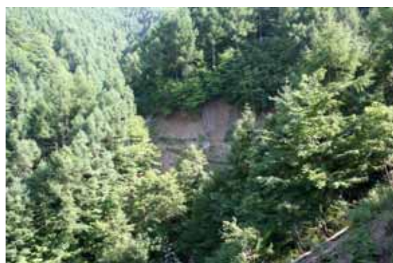
写真 4-18 花崗岩風化土の森林作業道崩壊状況（左）と崩壊全景（右）
