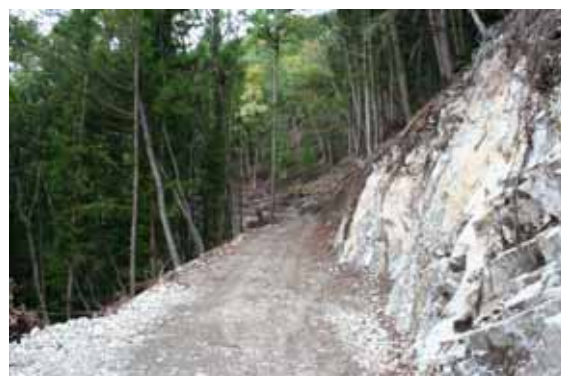
写真 4-16 ブレーカ掘削を行った岩盤
