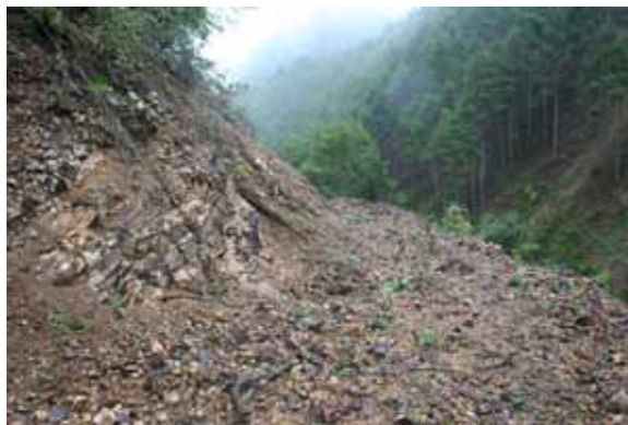
写真 4-20 第三紀砂岩泥岩互層（左）と凝灰岩質の脆弱な岩盤法面
