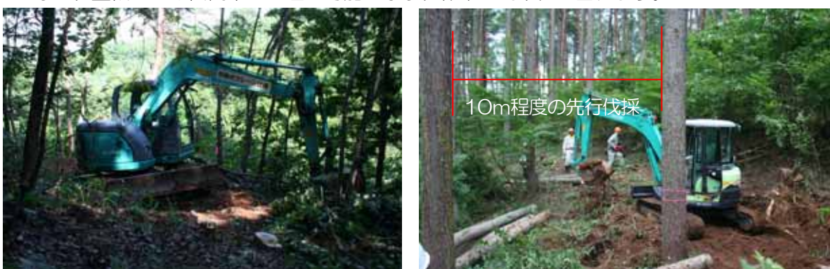
写真 4-5 先行伐採の状況（先線 10m 程度まで伐採）
